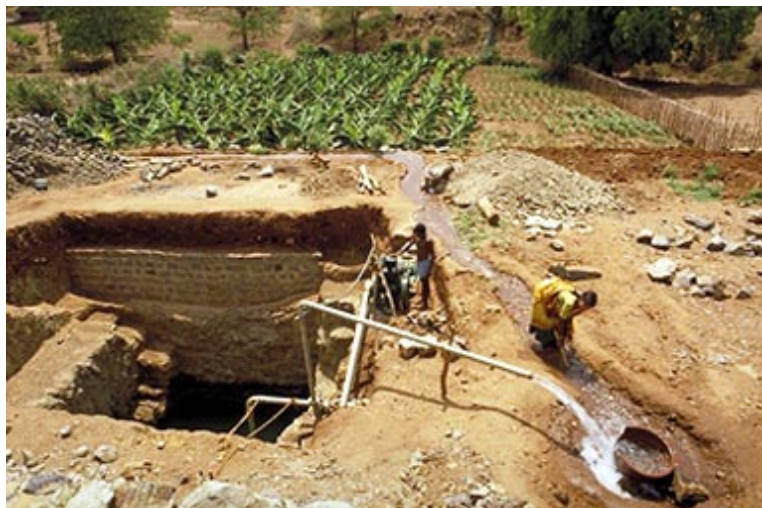
Foto 6: Pozo en el que se realizan trabajos de excavación e instalación de tuberías.
