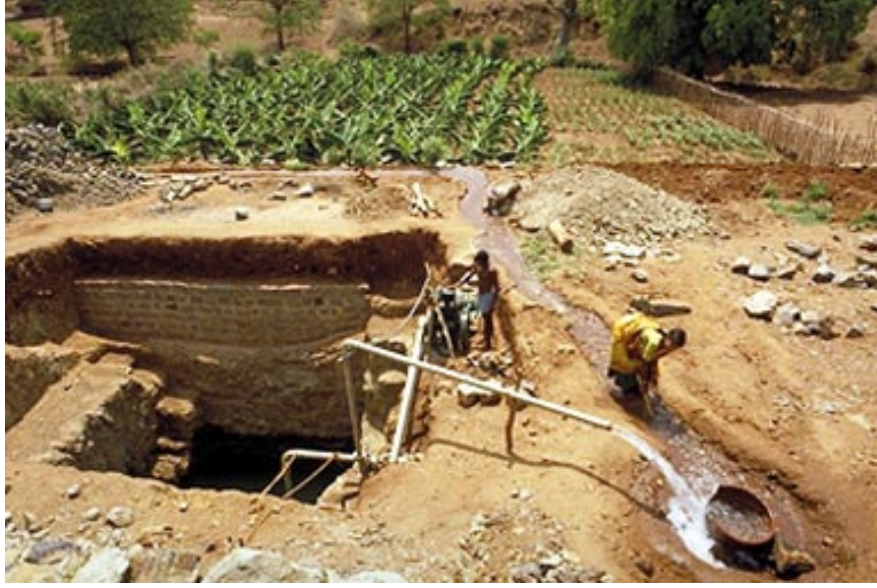
الصورة 6 صورة لبئر يتم تعميقه ووضع أنابيب فيه
