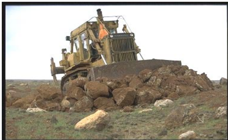
Las excavadoras limpian un terreno fértil cubierto por rocas volcánicas.
