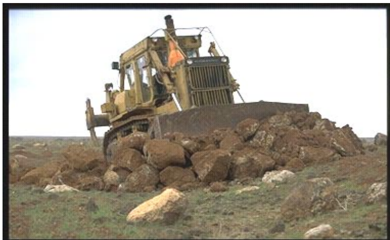
Des bulldozers déblaient un terrain fertile encombré de roches volcaniques
