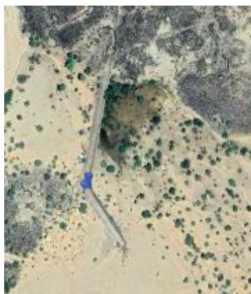
Seuil Abou Youssouf - Dikhil Projet : PROGRES Intervention : Construction Date : Décembre 2023 Localisation : 11,08315, 42,247189
