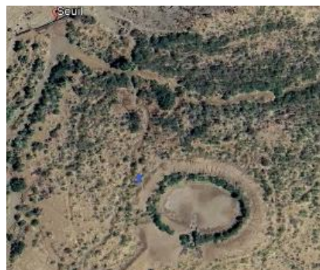
Retenue Harrougo - Dikhil Projet : PROMES Intervention : Construction Date : Décembre 2023 Localisation : 11.31847, 42.030111
