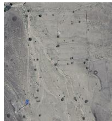
Seuil Bondara – Dikhil Projet : PROGRES Intervention : Construction Date : Juin 2024, Travaux CES
