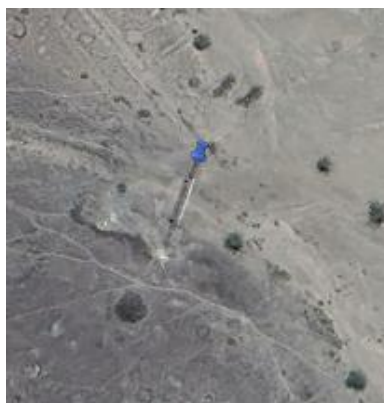
Seuil Bondara – Dikhil Projet : PROGRES Intervention : Construction Date : Juin 2024
