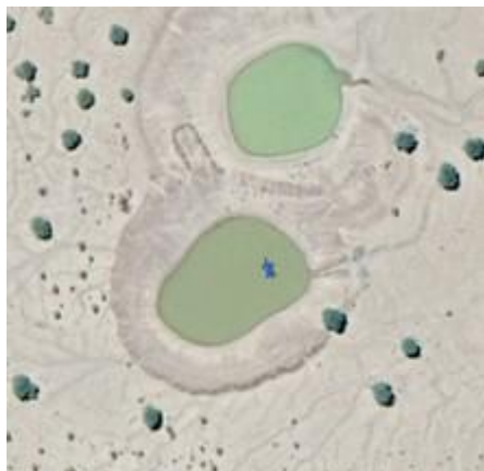
Retenue Garissa – Tadjourah Projet : PROMES Intervention : Construction Date : Février 2019 Localisation : 12.142779, 42.373743
