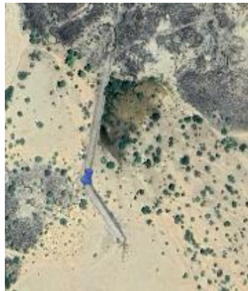
Seuil Abou Youssef - Dikhil Projet : PROGRES Intervention : Construction Date : Décembre 2023 Localisation : 11,08315, 42,247189
