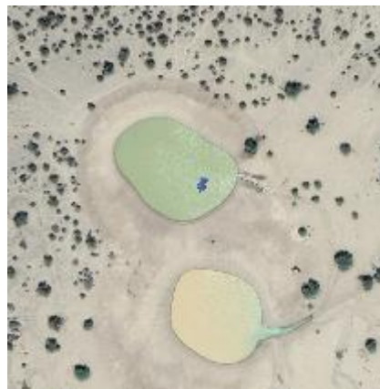
Retenue Garissa – Tadjourah Projet : PROMES Intervention : Construction Date : Août 2023 Localisation : 12.142779, 42.373743
