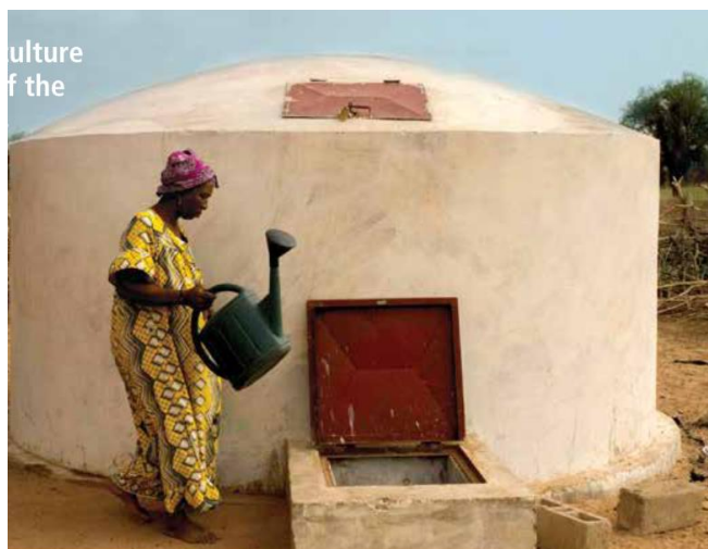
Figure 4. Des modèles pilotes de cisternes à possiblement revoir avec des pompes solaires pour la prise de l'eau.
