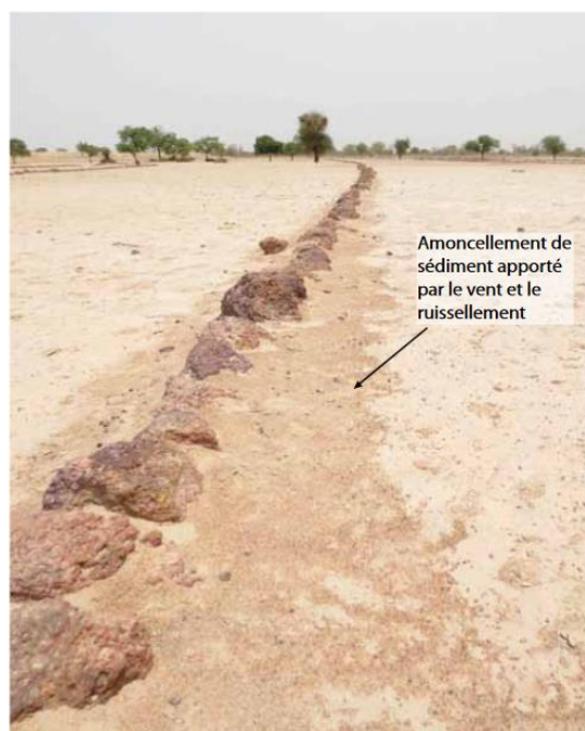
diguette antiérosive filtrante
