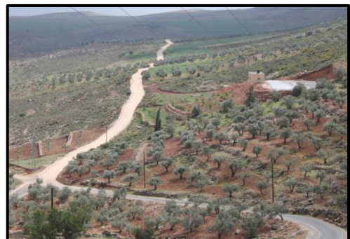
تشبيد طريق في عقبة بقضاء نابلس.
