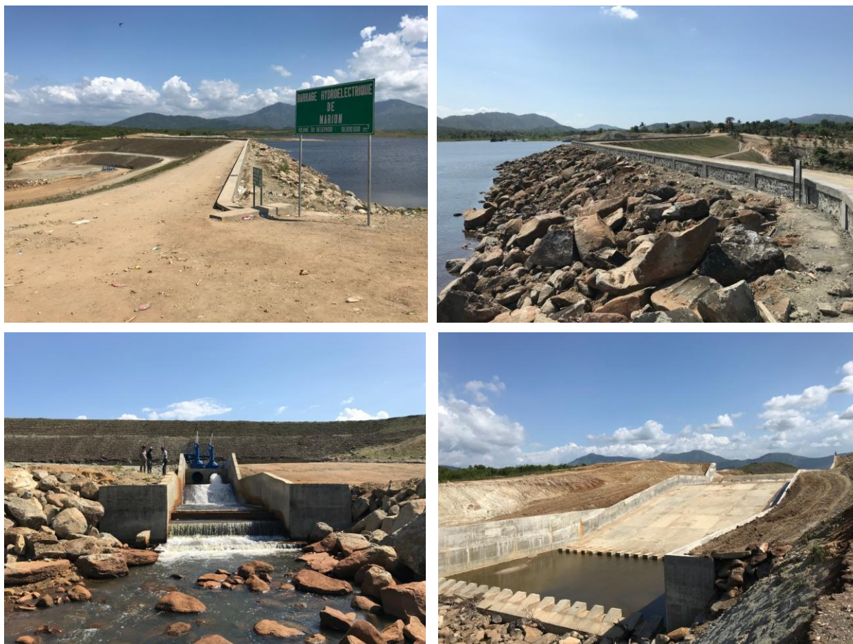
Figure 16. Quelques vues du nouveau barrage hydroélectrique de Marion
